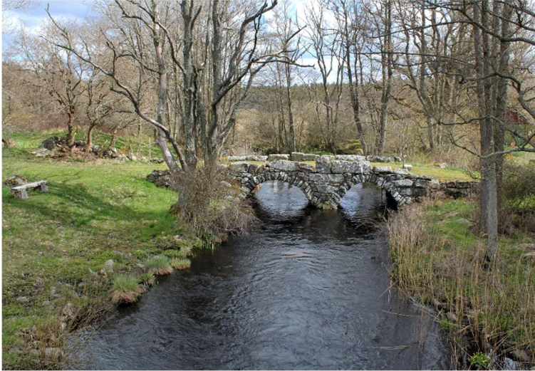
Gamla bron över Vierydsån sedd från nuvarande landsvägsbron. Till vänster ses den Väby tillhörande västra sidan av ån där lastageplatsen fanns.
