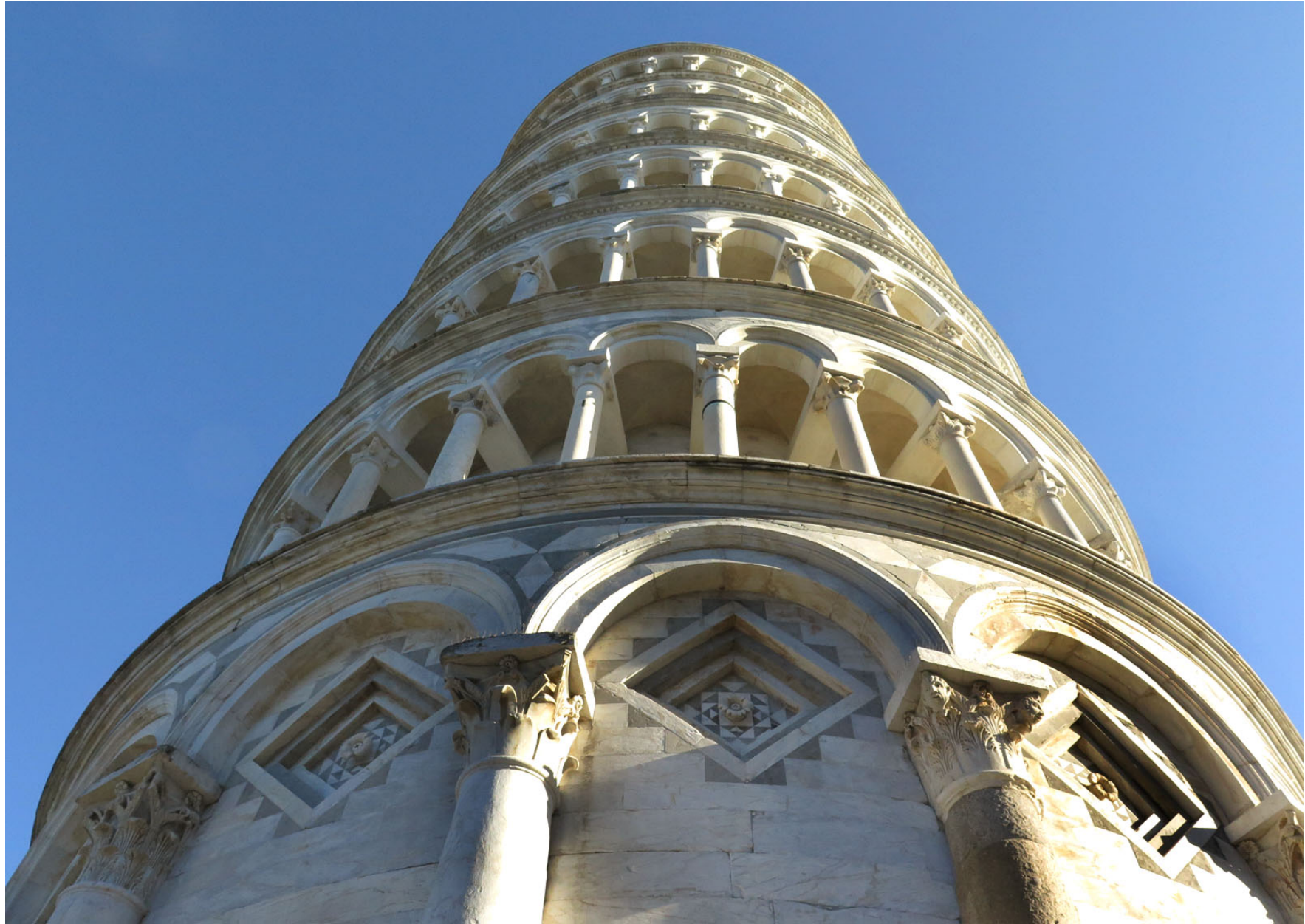
Det 55 meter höga Torre Perdente byggdes med början 1173 på mark bestående av sand och lera. Det stod klart 1350, men hade börjat luta redan innan tredje våningen var klar 1274.
