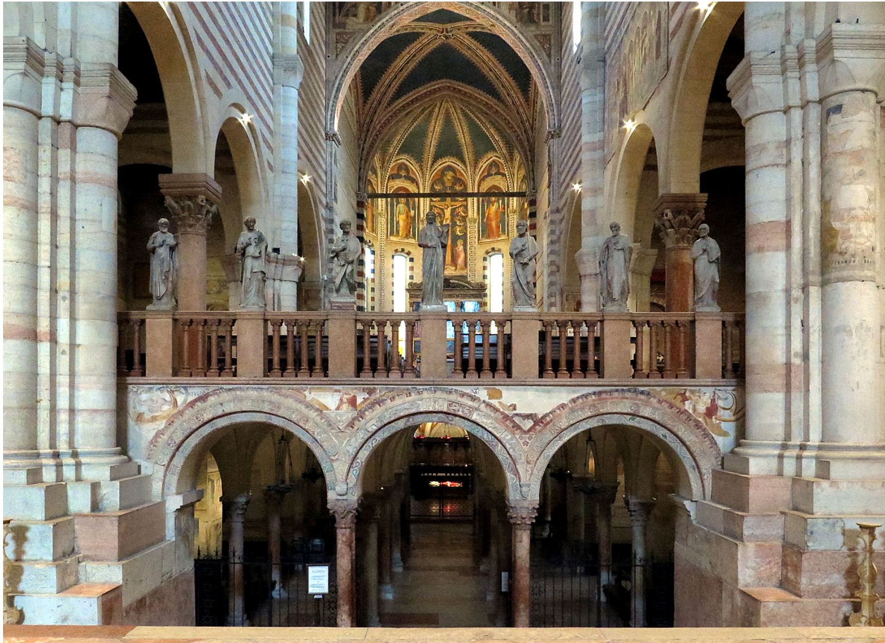
Kyrkan har tre nivåer: överst med högaltaret, sedan mittskeppet och därunder kryptan med helgonets relikier.
