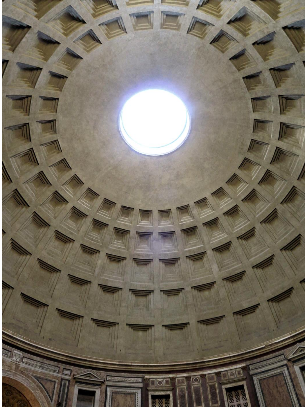
Pantheons kupol är lika bred som hög: 43,3 meter. Oculus, taköppningen, är 8,3 meter i diameter.
