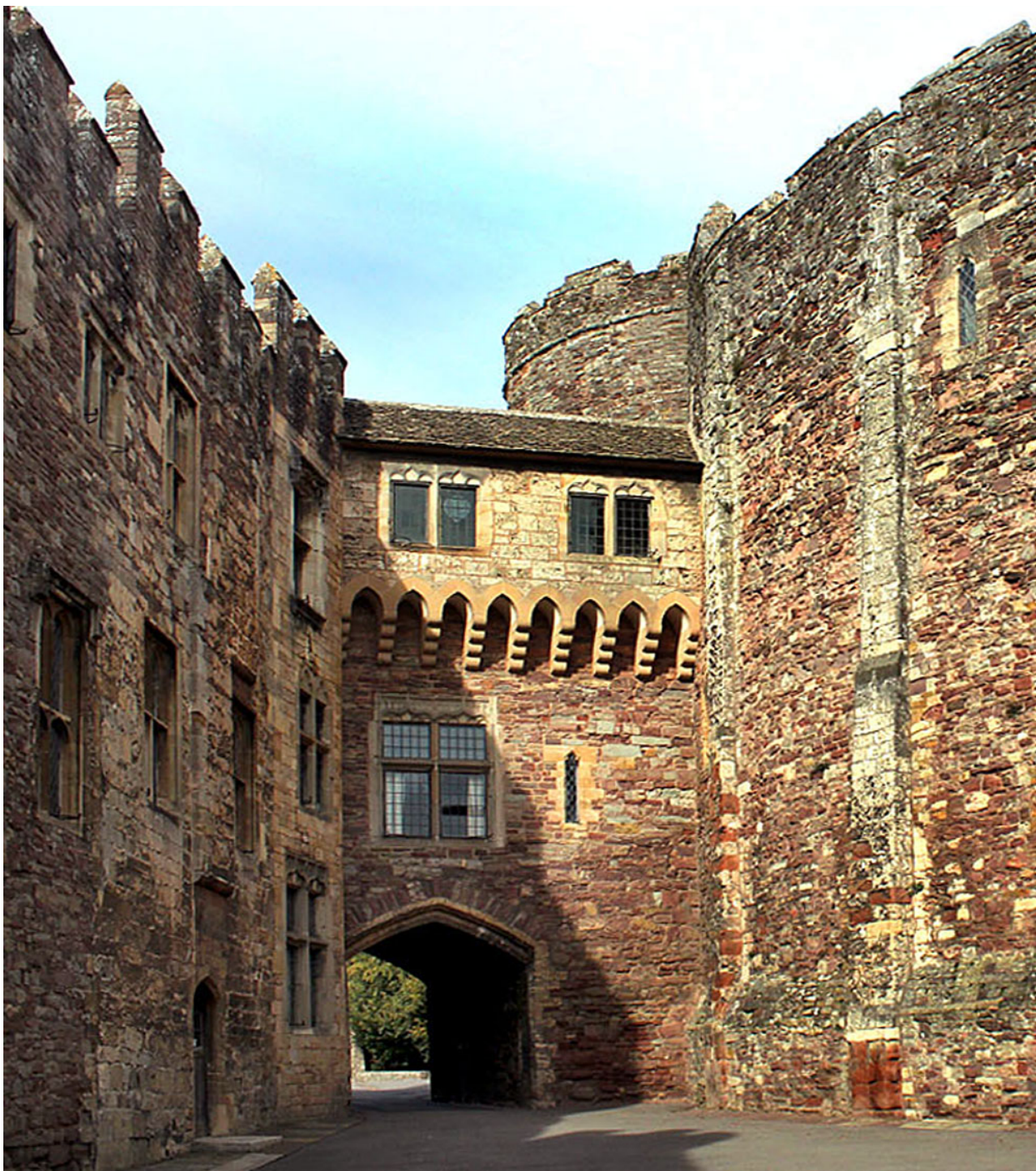
Porthuset från 1300-talet sammanbinder den gamla borgen (t.h.) med övriga byggnader.
