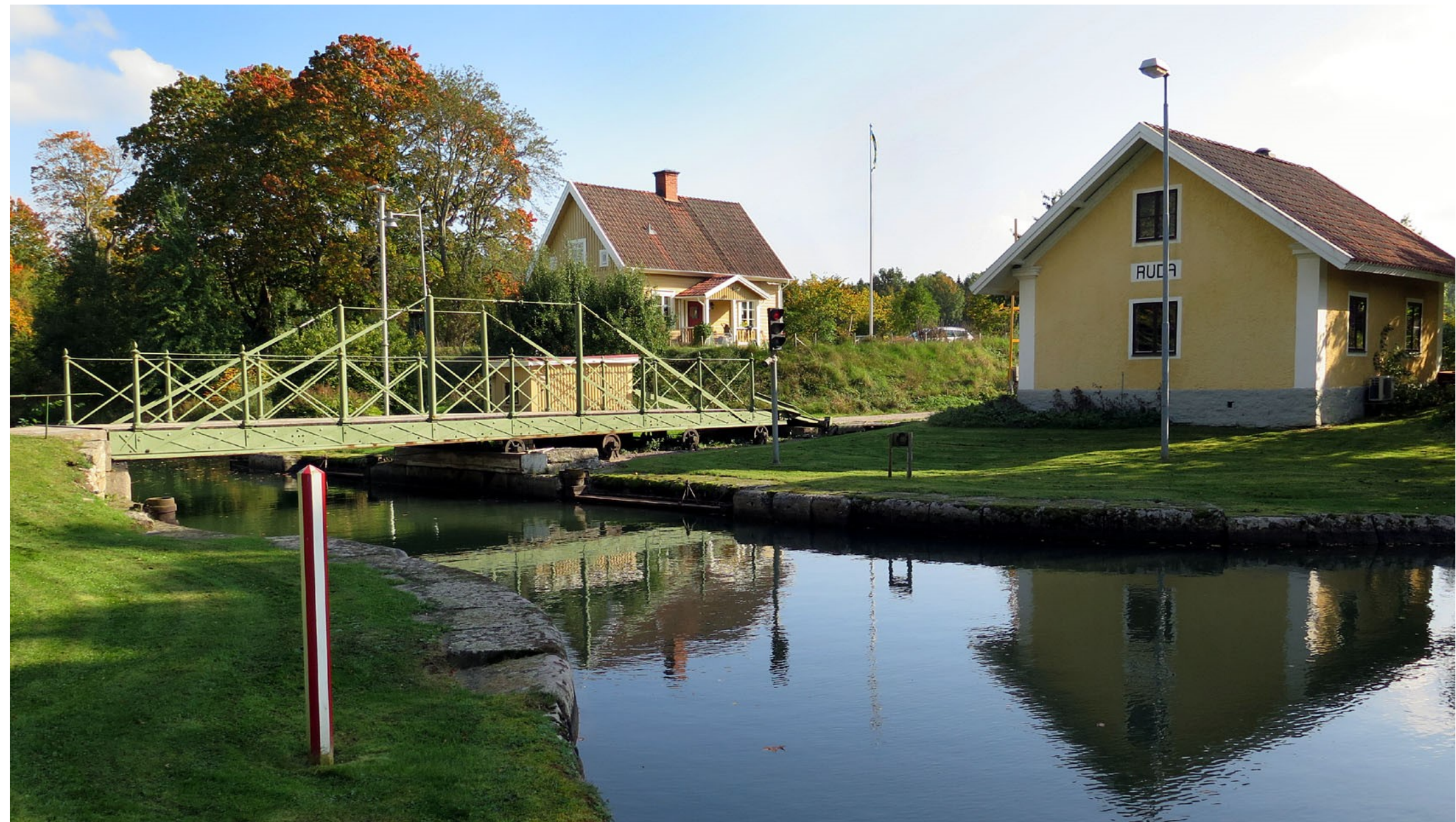
Ruda bro är en rullbro med spännvidden 7,5 meter, och som tål en belastning av 2,5 ton.
