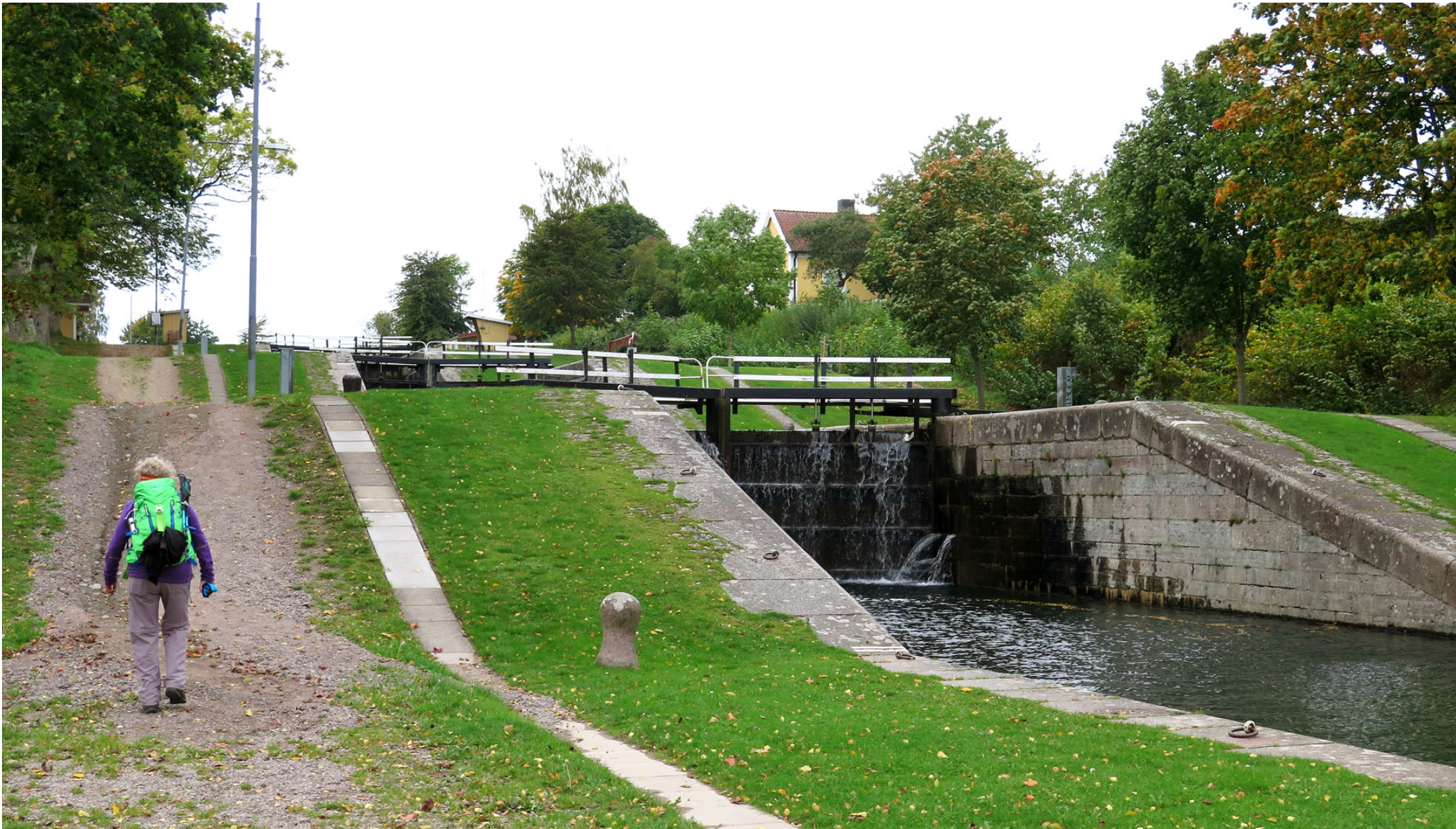
Efter ytterligare ett par timmar till fots passerar vi Borenhults slussar.
