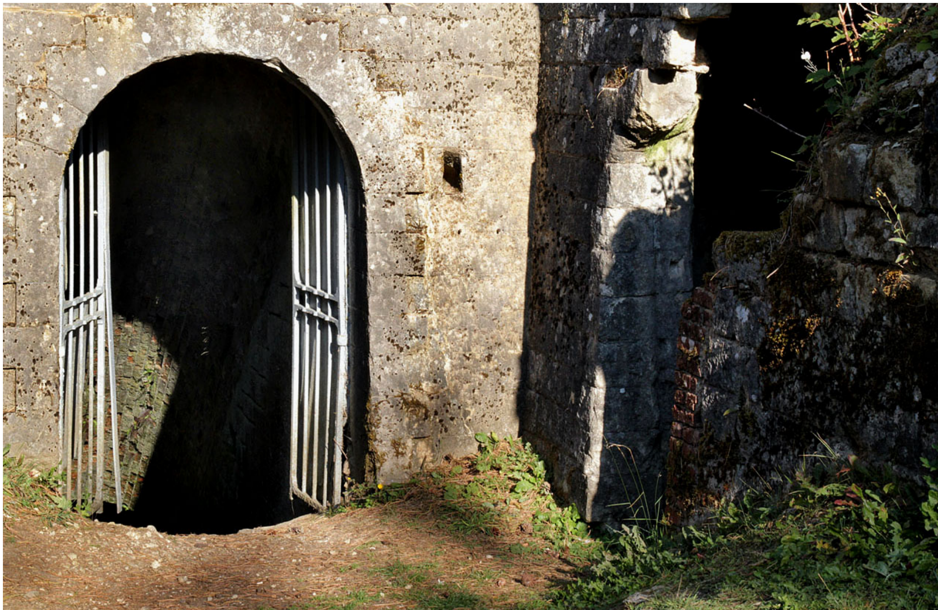
Bunkern byggdes omkring 1890 och bestod av en 60 meters tunnel 8 meter under jorden, och rymde 300 sängplatser.
