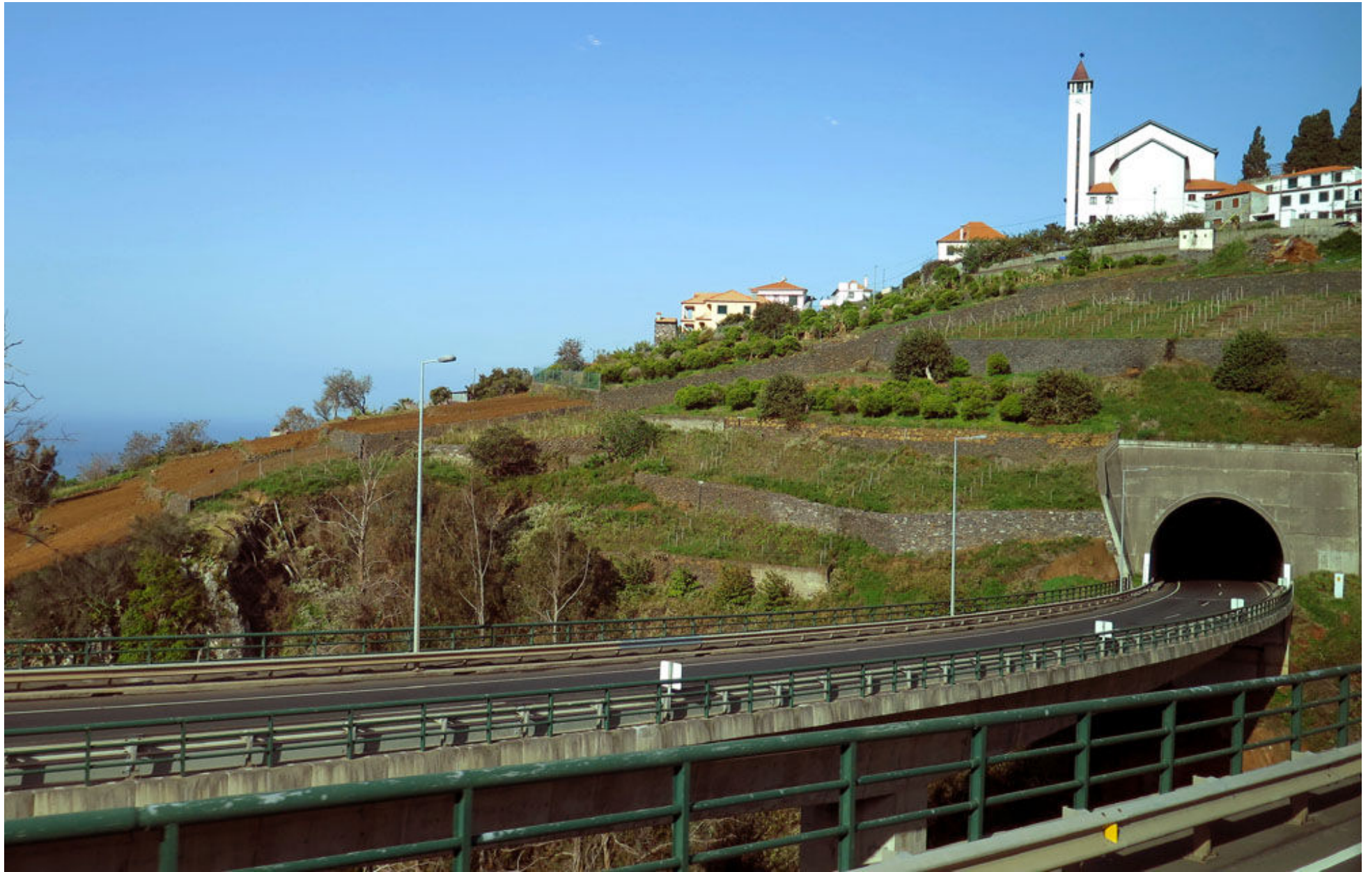
Madeira är en vulkanö och mycket bergig, men senare tiders tunnelbyggande har underlättat kommunikationerna.
