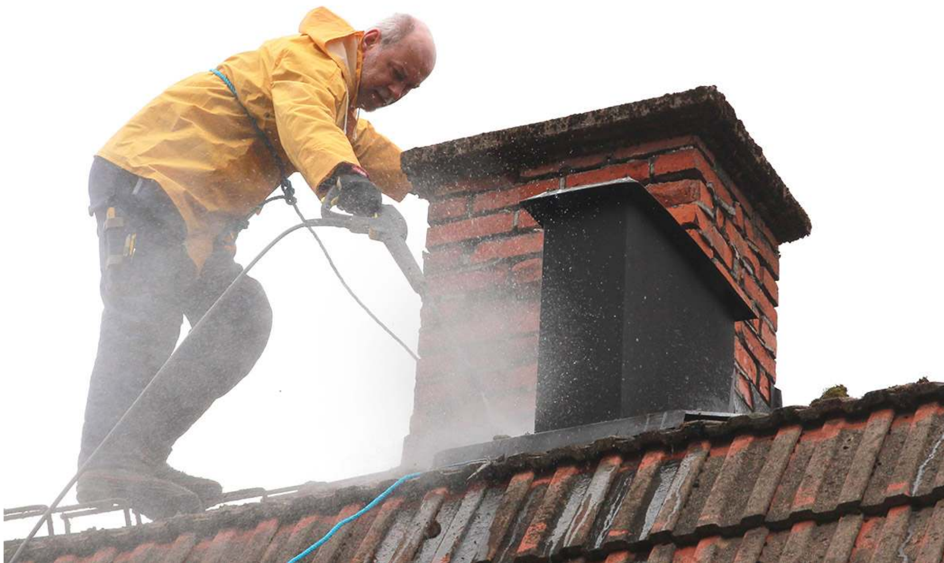
Mats jobbar för högtryck med att ta bort mossa från taket.
