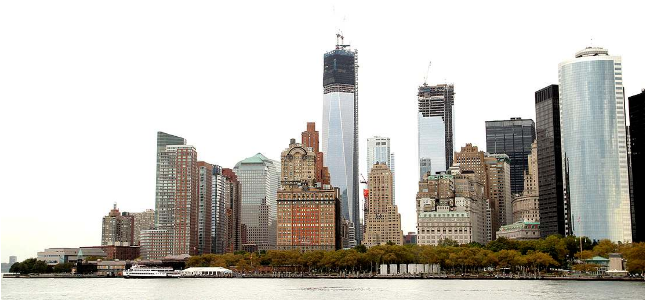
En bit norr om Battery Park på södra Manhattan pågår byggande av de två första skysraporna av sju till nya World Trade Center .
