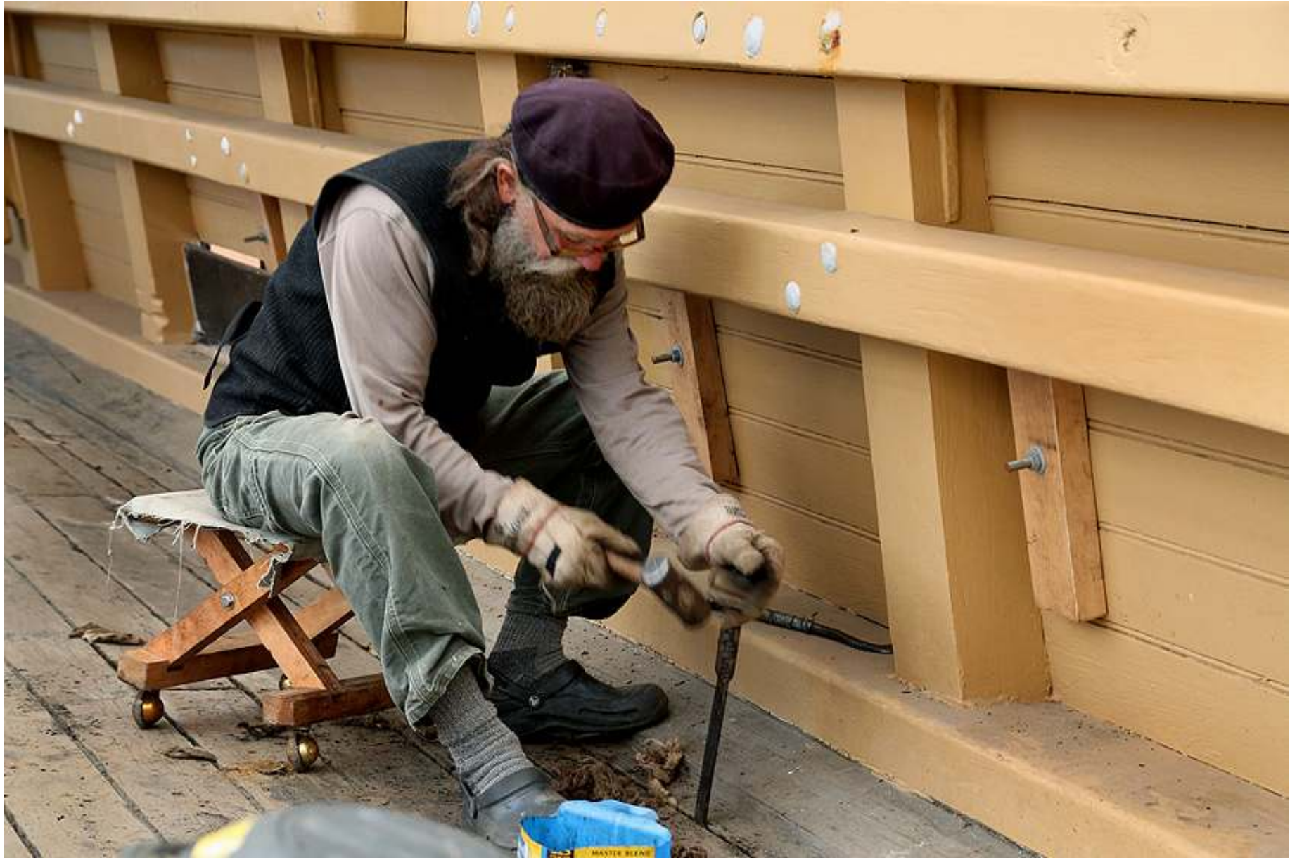
På muséets skeppsvarv pågår arbete med att restaurera gamla båtar, däribland det enda kvarvarande träbyggda valfångstfartyget, Charles W. Morgan , byggt 1841.
