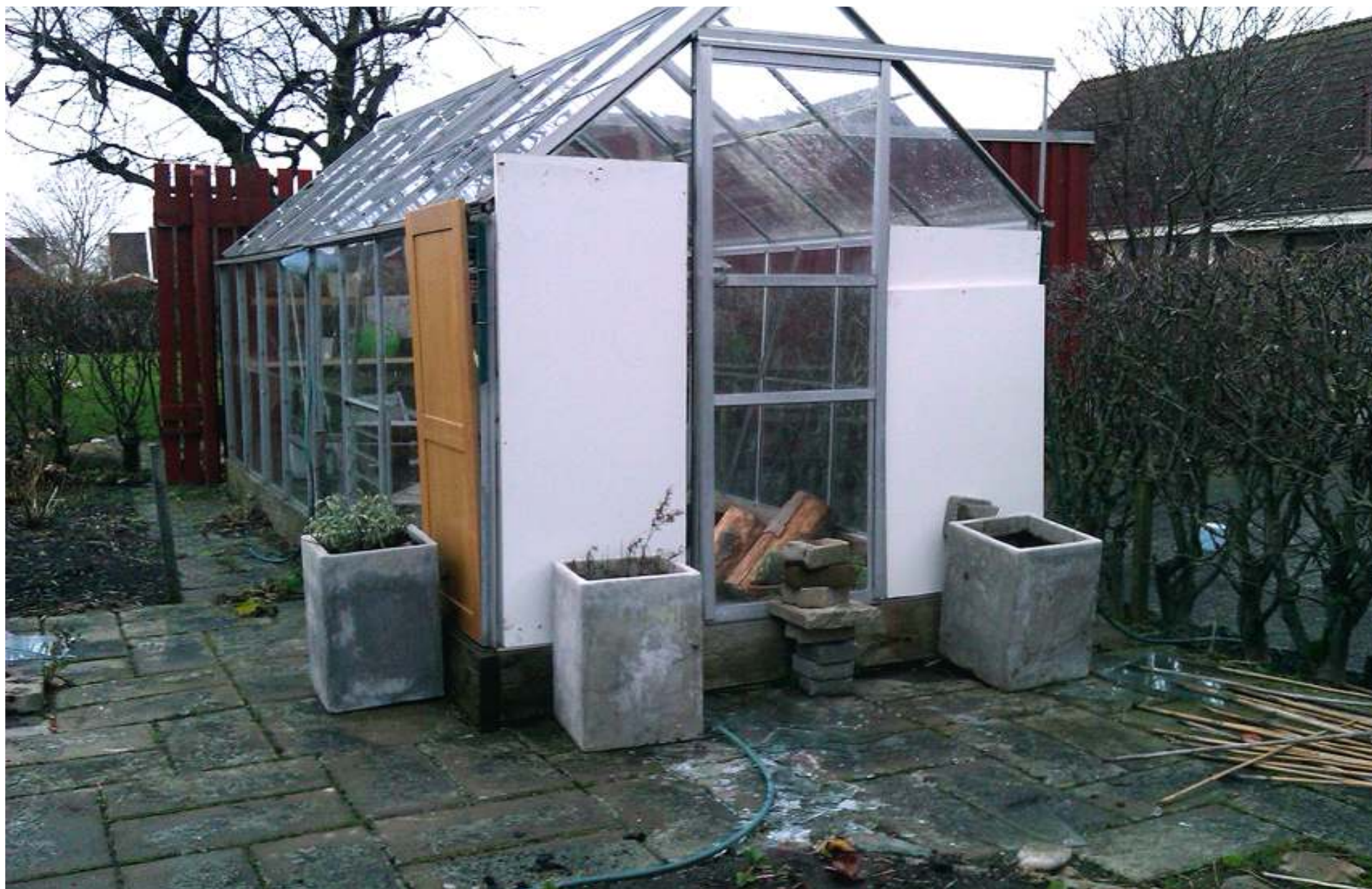
Hemma på Vindögatan slet blåsten sönder sju av växthusets glasrutor. Provisorisk lagning förhindrade ytterligare skador.
